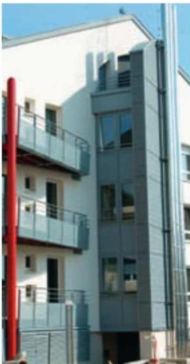
Aus diesem Blickwinkel wird die Konstruktion des Vorbaus und der Abgasanlagen besonders deutlich.
