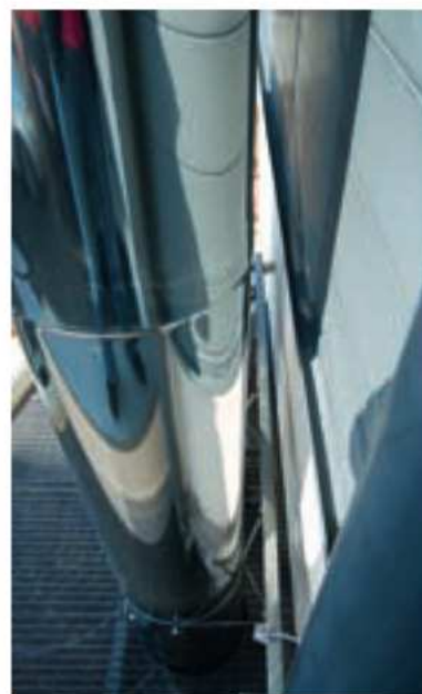
Die erste Wandhalterung von unten – an der durchgehenden Schiene sind alle drei Abgasanlagen befestigt.
