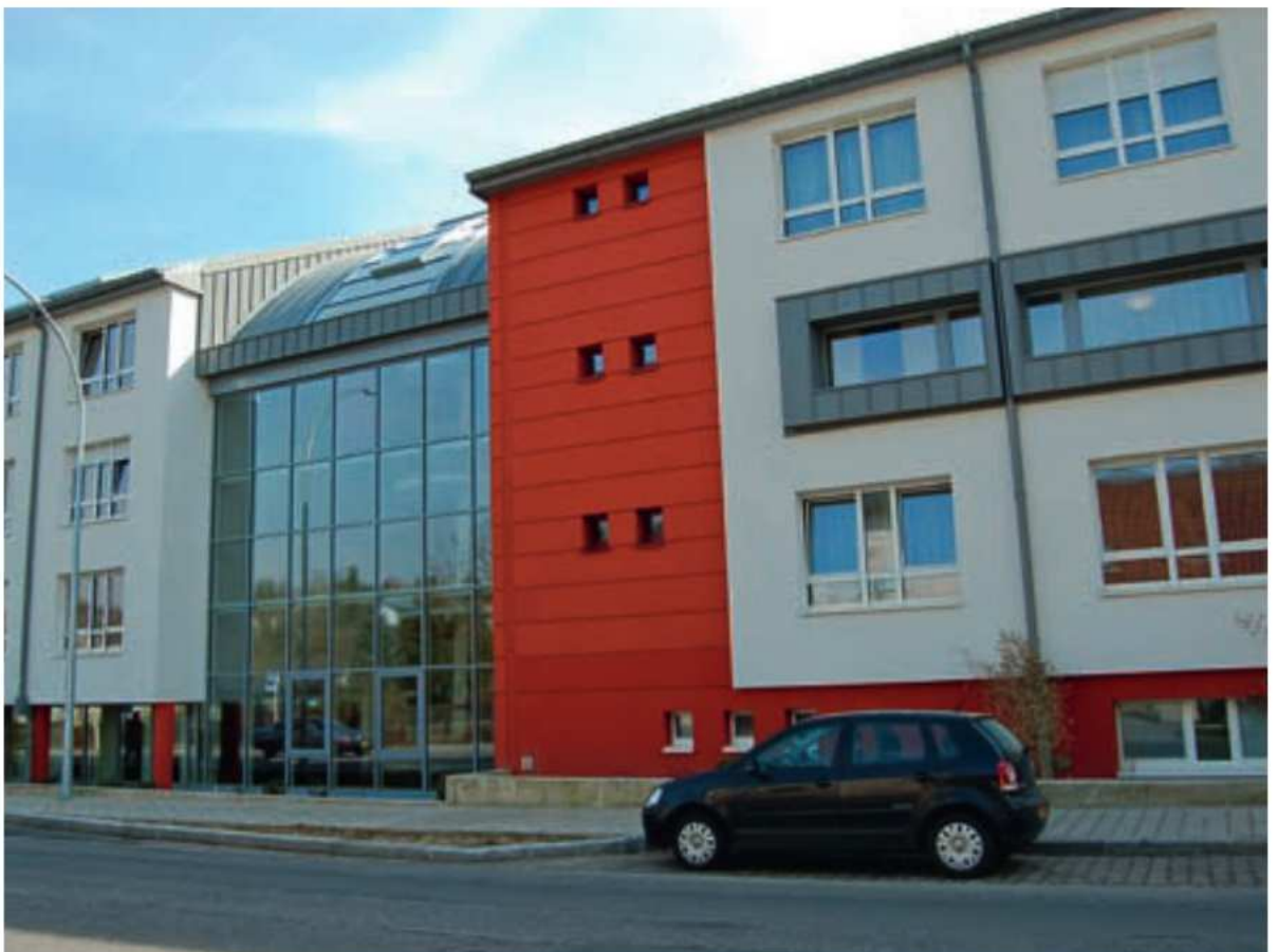
Das gegliederte Gebäude von der Straßenseite aus gesehen.
